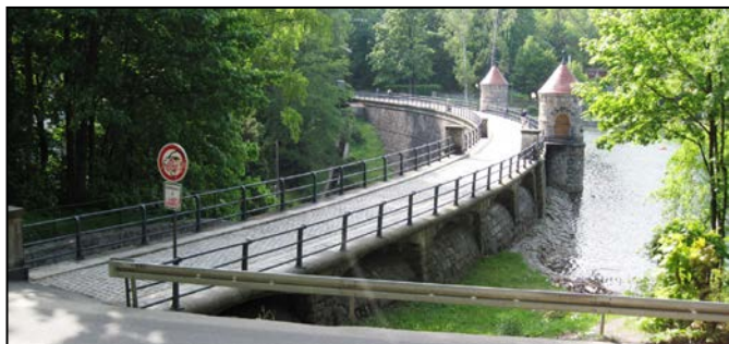
Obr. 2: Foto bezpečnostního přelivu, přehrady a přístupových věží k uzávěrům spodních výpustí na VD Harcov
