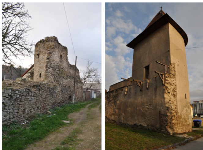
Obr. 2: Bašta 5o s príľahlým hradbovým múrom (vľavo) je autenticky zachovaná, bašta 10o (vpravo) prešla komplexnou rekonštrukciou v 90-tych rokoch 20. storočia, zdroj: autorka príspevku
